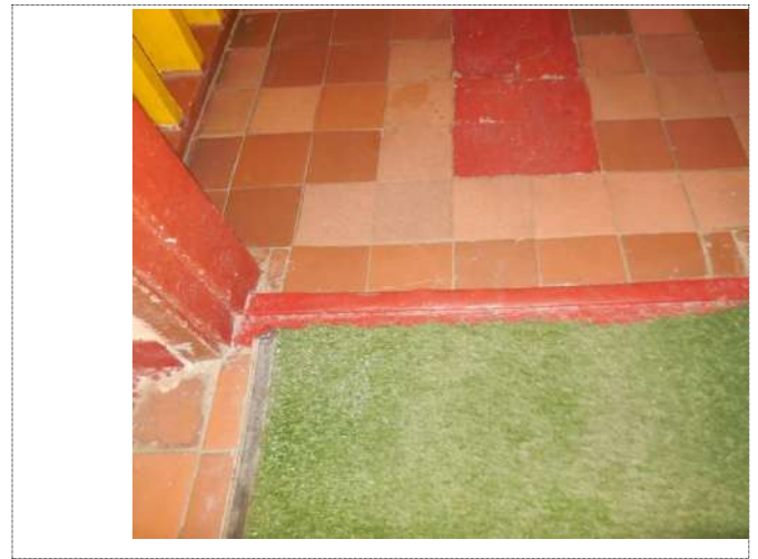
Фото 12 Внутренняя входная дверь
