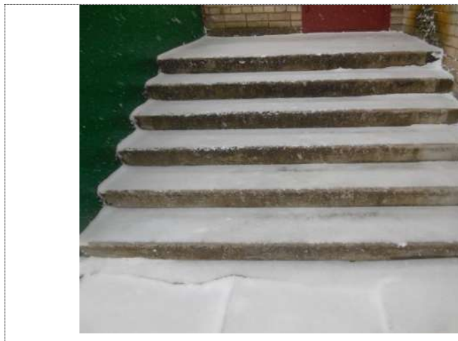
Фото Лестница наружная главного входа
