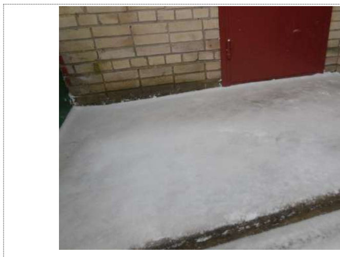
Фото 8 Входная площадка главного входа
