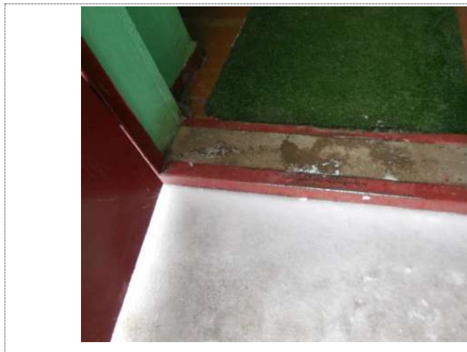
Фото 10 Наружная входная дверь
