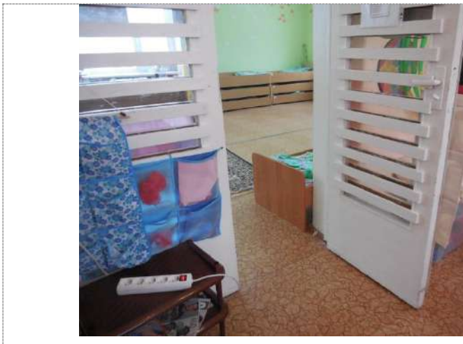
Фото 19 Пути движения внутри здания (двери)
