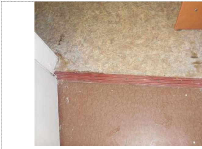
Фото 21 Пути движения внутри здания (двери)
