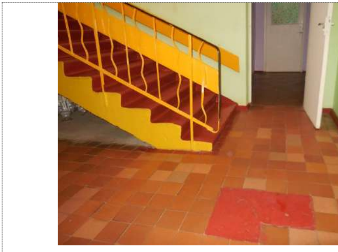
Фото 17 Пути движения внутри здания (лестницы)
